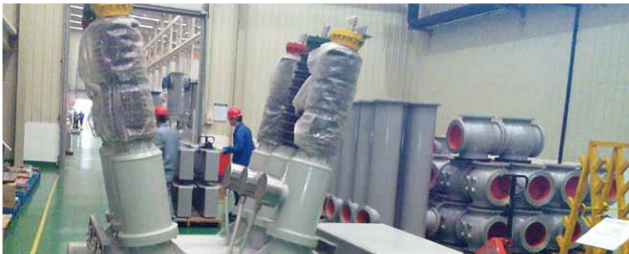
Рис. 6.3 Разъединитель типа GW4-126IIDW
